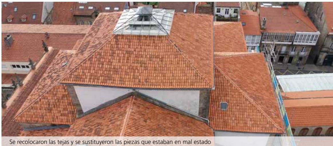
Se recolocaron las tejas y se sustituyeron las piezas que estaban en mal estado
