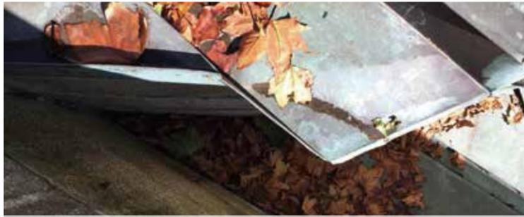
Las cubiertas del vestíbulo y del pasillo de la sala circular filtran el agua de la lluvia
