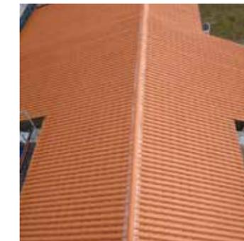
Se renovaron las tejas de la cubierta, que se levantaban cuando había temporal
