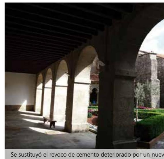
Se sustituyó el revoco de cemento deteriorado por un nuevo revoco deshumidificante
